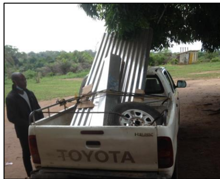
Dès qu'il y a un peu de financement, les travaux reprennent !
